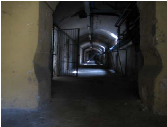
Corridoio del corpo centrale della caserma da cui si accede alle celle
