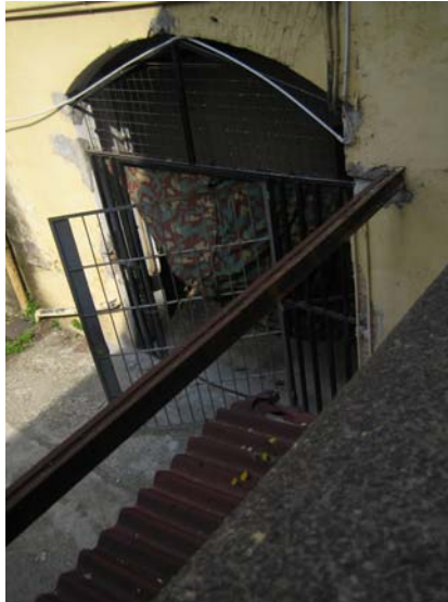
Accesso al corridoio del corpo centrale della caserma
